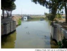
OBRA CIVIL DE LA IL·LUSTRACIÓ
